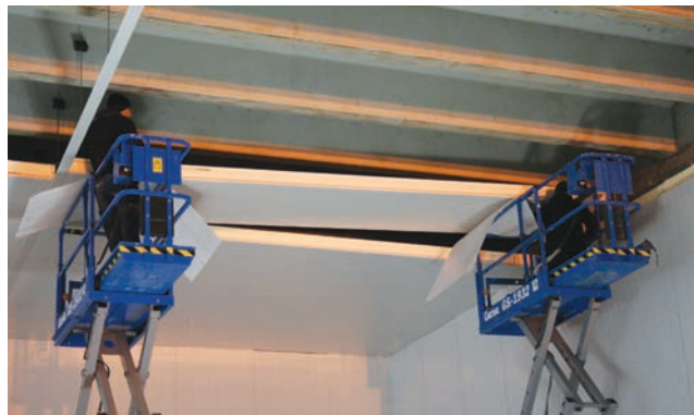
Uppsetning í fullum gangi á frystiklefaeiningum hjá Ölgerðinni Grjóthálsi
