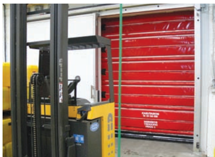
Nergeco Frigo 3 frystiklefahurð hjá Garra hf.
