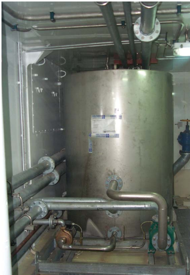
Alsjálfvirkur blöndunartankur sem blandar saman vatni og sjó. Með þessu móti er hægt að velja mun lægri saltþrósentu í krapann sem er mjög hentugt þegar unnið er með flök þannig að þau verði ekki of sölt.
