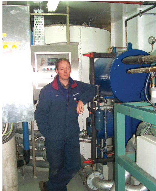
Sigurður í Kælitækni fyrir framan krapatankinn í Engey. Tankurinn er 6 m á hæð og nær í gegnum eitt þilfar. Sigurður styður hendi sinni við eimi forkælis.
